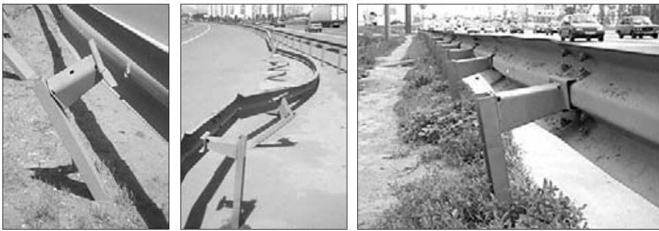
Рисунок 3.2.11 – Иллюстрации различных этапов работы односторонних ограждений
