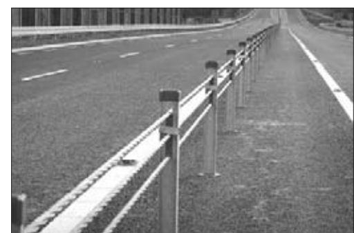
Рисунок 3.2.9 – Пример использования тросового ограждения
