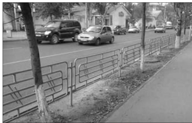
Рисунок 3.2.13 – Пример использования пешеходных ограждений
