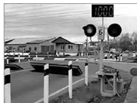
Рисунок 3.15.4 – Пример предлагаемого светодиодного табло с цифровым оповещением об оставшемся времени до закрытия переезда
